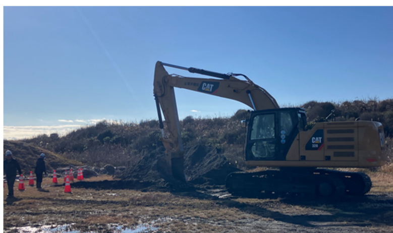
2025 年 12 月 22 日 茨城県ひたちなか市殿山町県有地での埋却の様子
