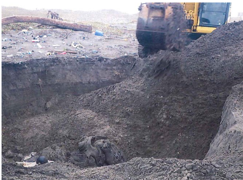
2025 年 10 月 16 日 茨城県神栖市波崎地先での埋却の様子
